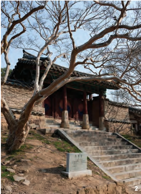
1 시간을 거슬러 올라가 고려 시대에 그 시원을 두고 있는 병산서원 새벽 물안개라도 피어오르면 절로 시인이 된다. 2 사람은 그만큼 살 수도 없겠지만, 산다 한들 그 세월이 저 리어름다울 수 있을까. 수백 년 풍상을 맨몸으로 버틴 배롱 나무 앞에 서면 절로 고개가 숙여진다. 3 사람 손이 덜 탄 만대루의 기둥이며 대를보가 마치 지금도 숨을 쉬는 듯하다. 4 사진 속 내체의 처마가 마치 아귀를 맞춘 것처럼 보인다. 5 흰 것은 흰 채로, 끈은 것은 또 그렇게 세워 집을 머리에 이고 사람을 이었다.
